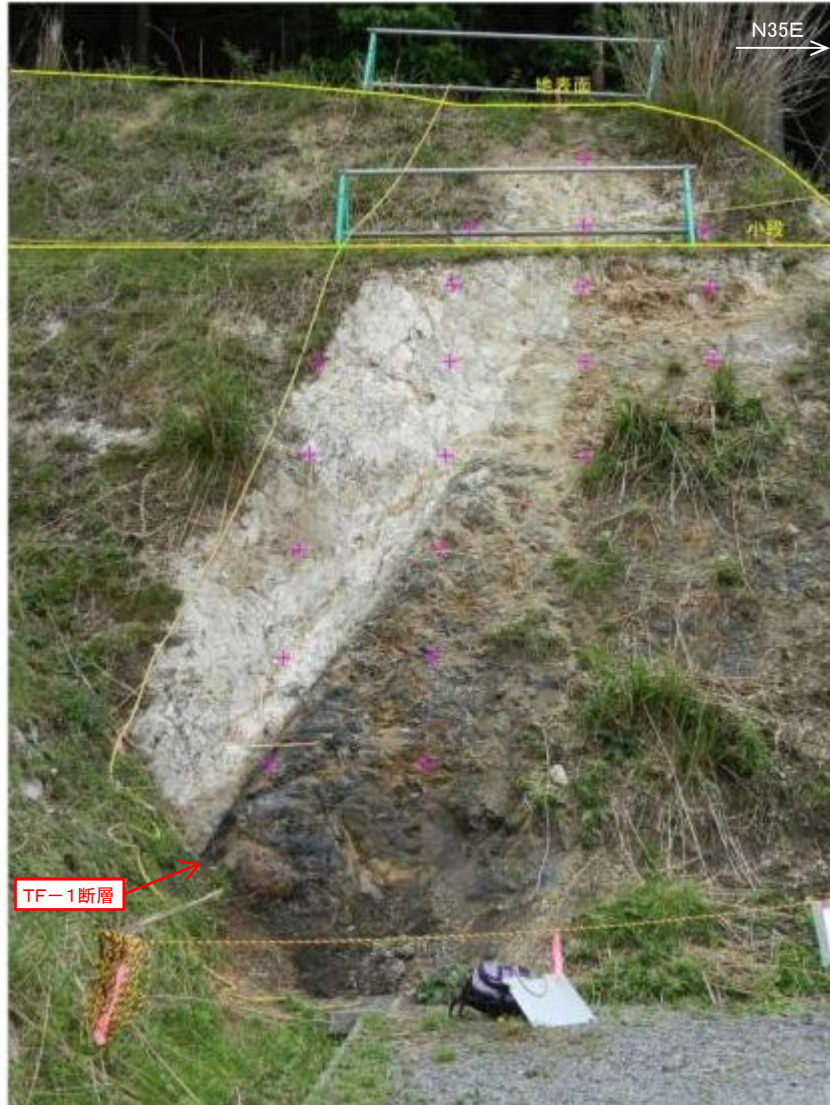
TF-1断層露頭写真
