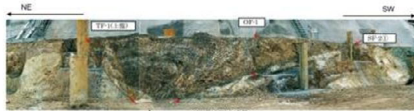
<観察法面の法面>
