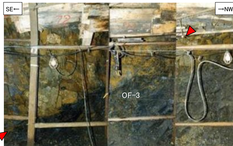
2号炉試掘坑A坑南西壁で確認したOF-3断層(左:写真, 右:スケッチ)
