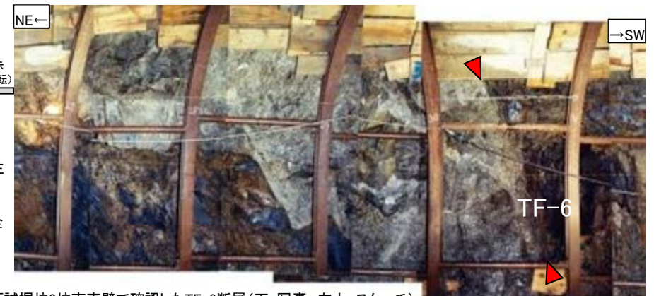
3号炉試掘坑2坑南東壁で確認したTF-6断層(下:写真, 左上:スケッチ)
