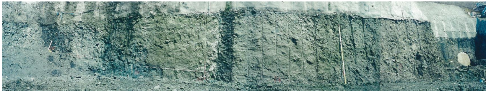
①原子炉建屋北側法面西側写真(T.P.-5m~-9m付近)
