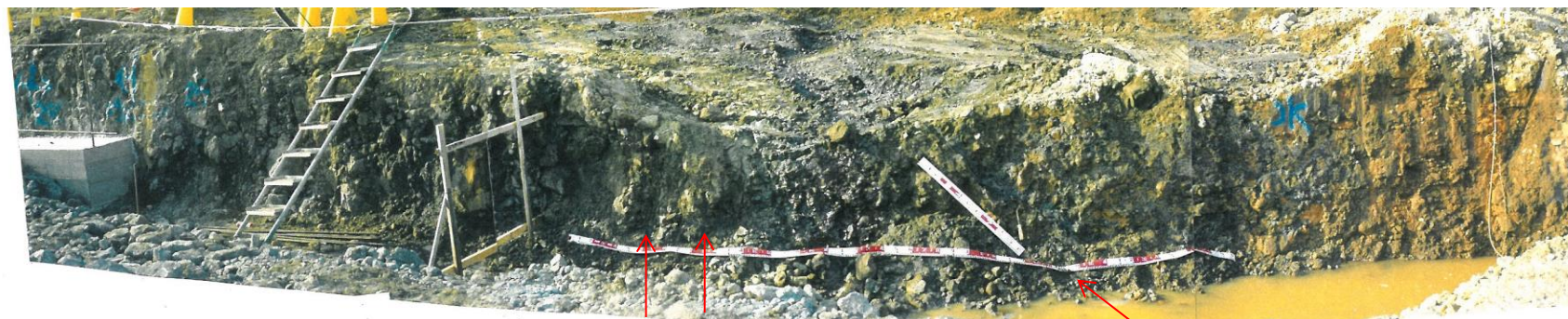
VT-2 ①タービン建屋北側法面写真（T.P.0m～-2m） f-1断層
