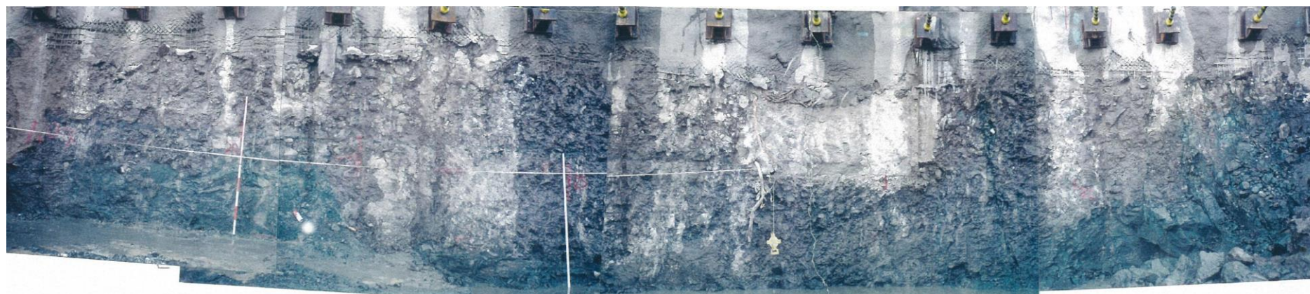
原子炉建屋南側法面写真(T.P.-14m~-17m)
