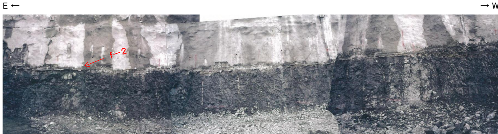
タービン建屋南側法面写真(T.P.-10m~-13.8m)
