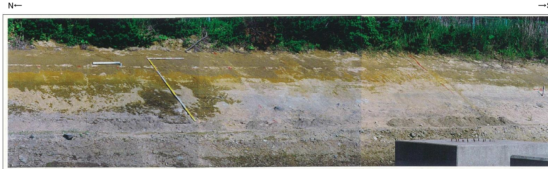
東側法面写真
