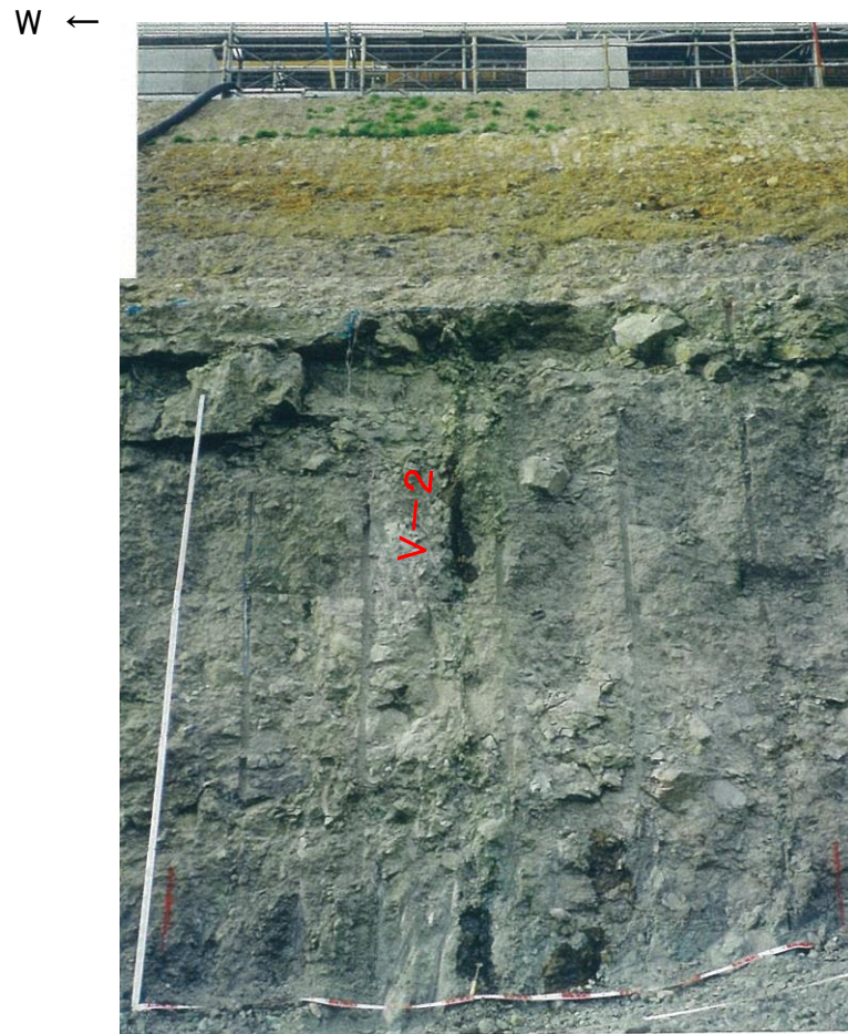
原子炉建屋北側法面写真
