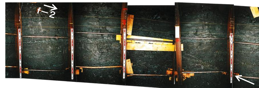
試掘坑西壁写真
