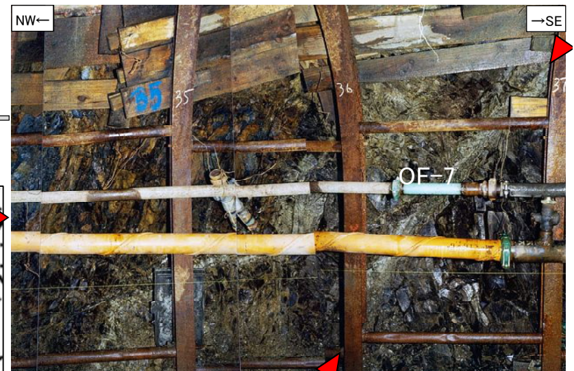
3号炉試掘坑1坑北東壁で確認したOF-7断層(右:写真, 左:スケッチ)
