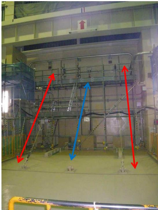
— : 電動ワイヤー巻取装置による開閉
