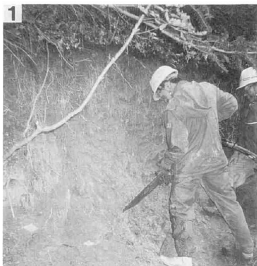
ダイヤモンドカッターを用いた定方位試料採取状況
