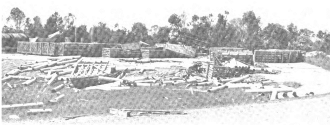
図 10 Grand Gulf 原子力発電所資材置き場におけるパイプの散乱状況
