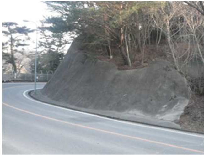
図1 道路法面モルタル吹付工の施工例（構内道路）
