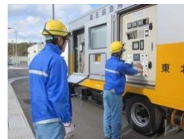
⑧電源車起動
