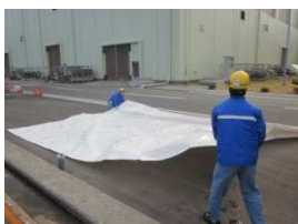
⑤ケーブル保護シート布設
