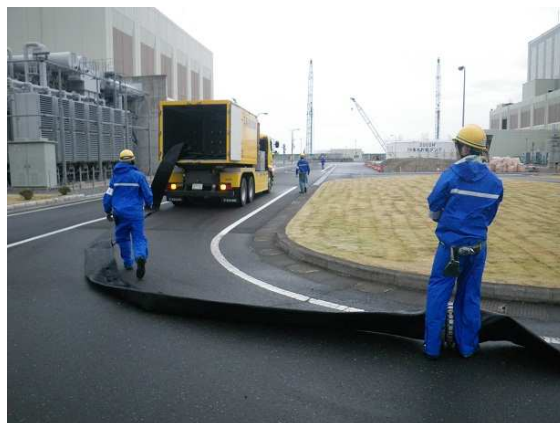
車両による海水送水ホースの設置
