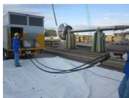
⑥ケーブル布設
