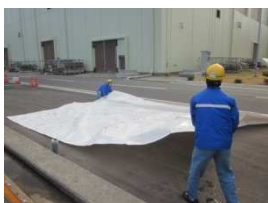
⑤ケーブル保護シート布設
