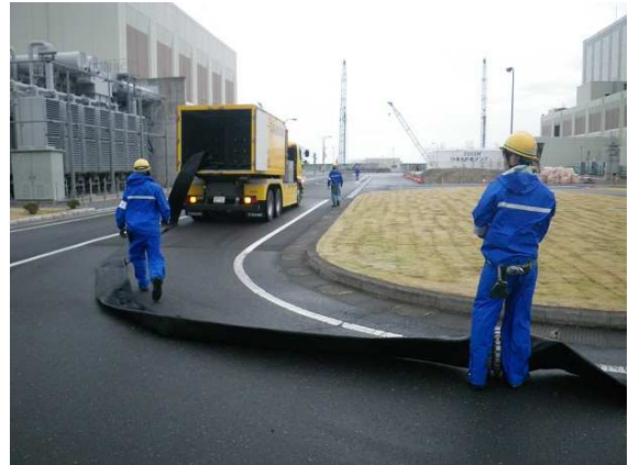
車両による送水用ホースの設置
