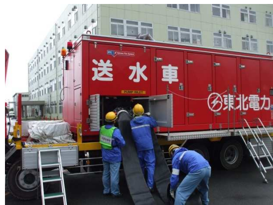
取水用ホースの接続
