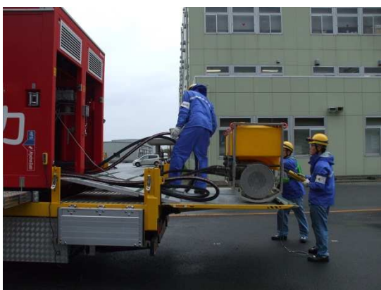
水中ポンプの取り出し
