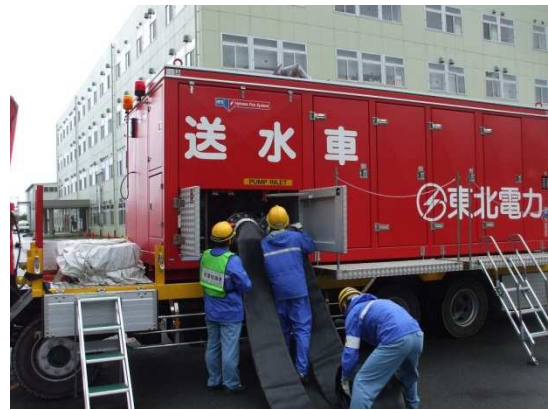
取水用ホースの接続
