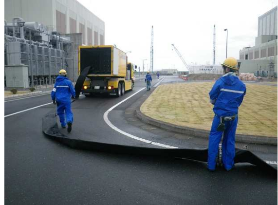
車両による送水用ホースの設置
