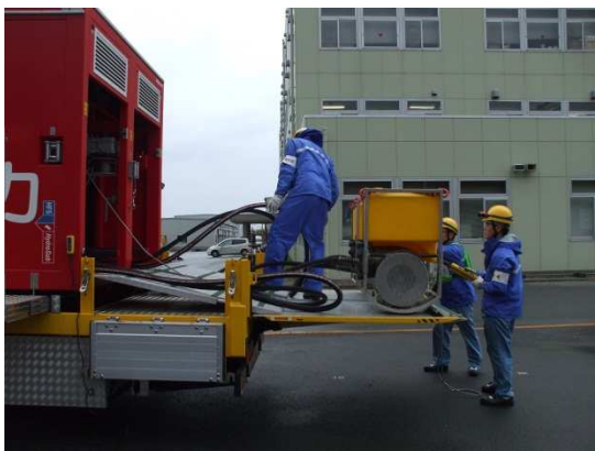
水中ポンプの取り出し
