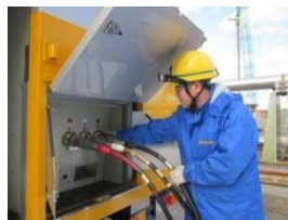
⑦ケーブル接続
