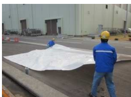
⑤ケーブル保護シート布設
