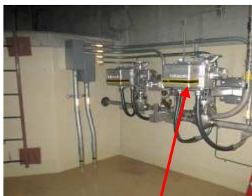
HPIN 常用非常用窒素ガス連絡弁
