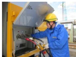
⑦ケーブル接続
