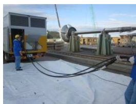
⑥ケーブル布設
