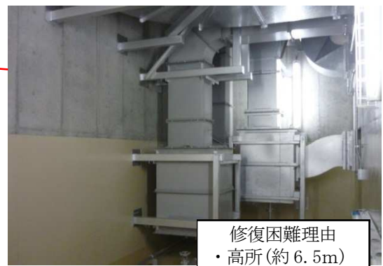
図3 MCR空調足場設置困難箇所
