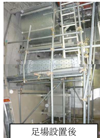
図4 MCR空調ダクト修復箇所足場設置モックアップ状況
