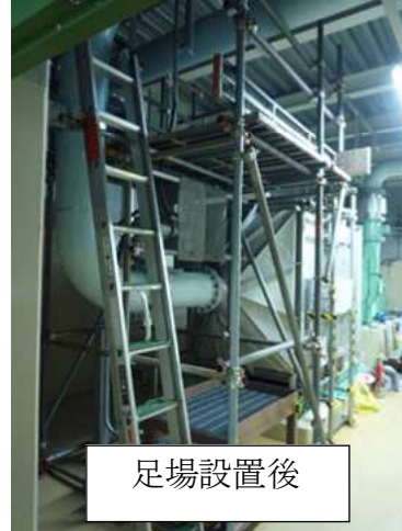
図2 SGT S配管修復箇所足場設置モックアップ状況
