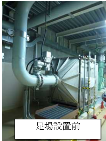
図2 SGT S配管修復箇所足場設置モックアップ状況
