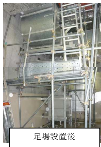
図4 MCR空調ダクト修復箇所足場設置モックアップ状況
