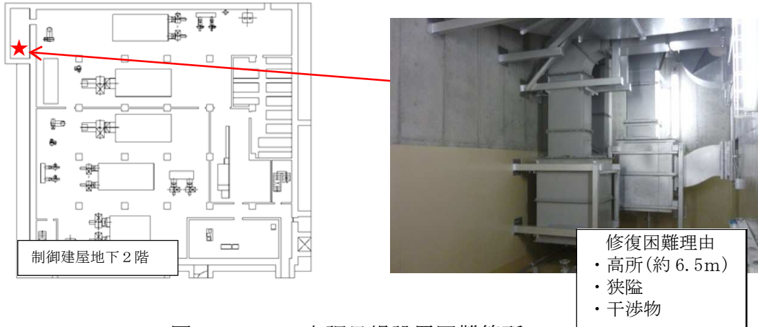
図3 MCR空調足場設置困難箇所
