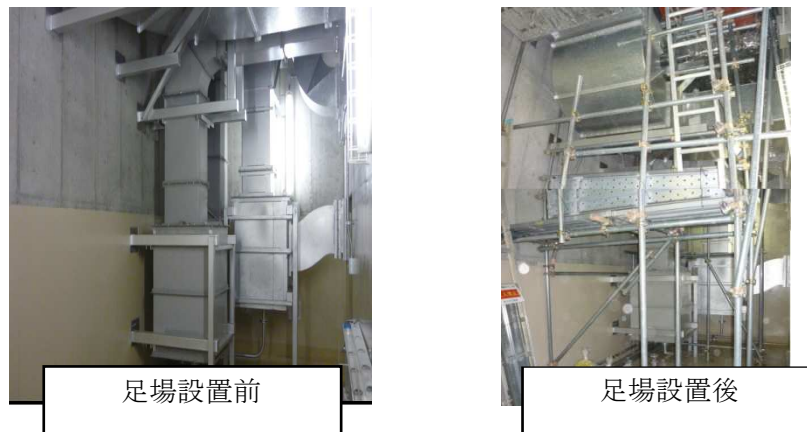
図4 MCR空調ダクト修復箇所足場設置モックアップ状況
