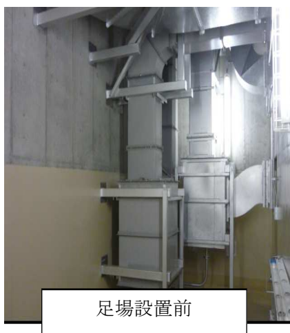
図4 MCR空調ダクト修復箇所足場設置モックアップ状況
