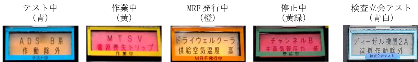
図 2.4 警報窓カバーによる識別
