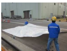
⑤ケーブル保護シート布設
