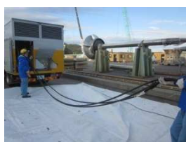
⑥ケーブル布設
