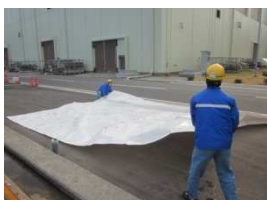
⑤ケーブル保護シート布設
