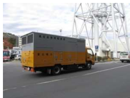
③電源車移動
