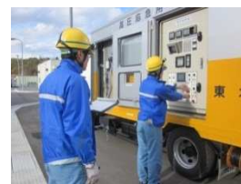
⑧電源車起動
