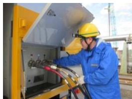
⑦ケーブル接続
