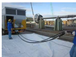
⑥ケーブル布設
