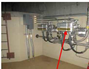
HPIN 常用非常用窒素ガス連絡弁
