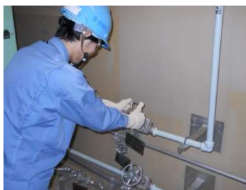
負荷切り離し作業 (空調機冷却水ライン)
