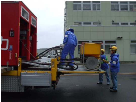
水中ポンプの取り出し
