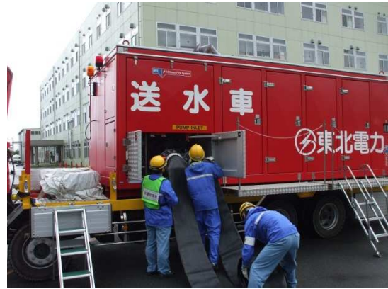
取水用ホースの接続
