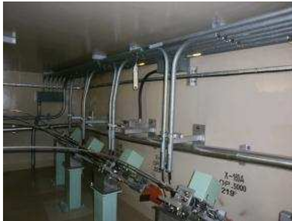
電線管および可とう電線管
