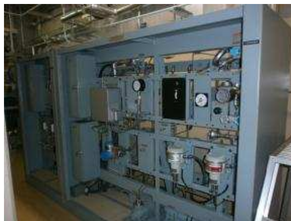
CAMS ラックおよび可とう電線管
