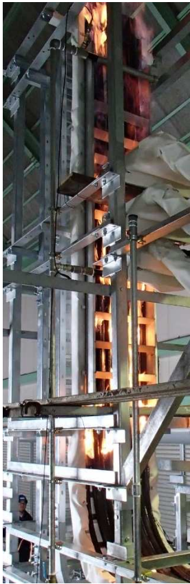
ケーブル火災状況
