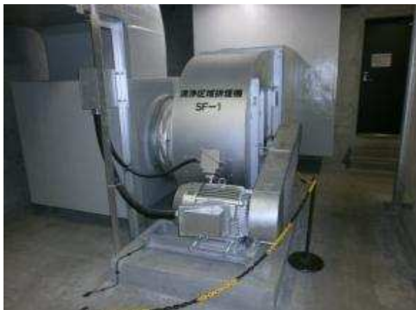
電線管および可とう電線管
