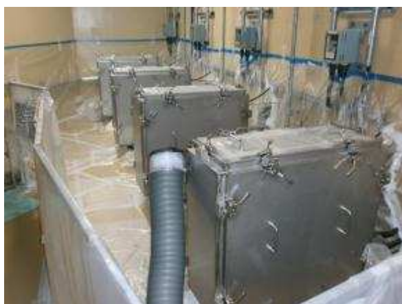
装置本体および可とう電線管
