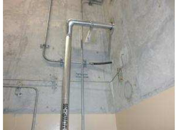
電線管および可とう電線管
