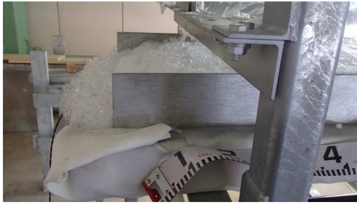
図 5 消火後の泡消火剤付着状況
