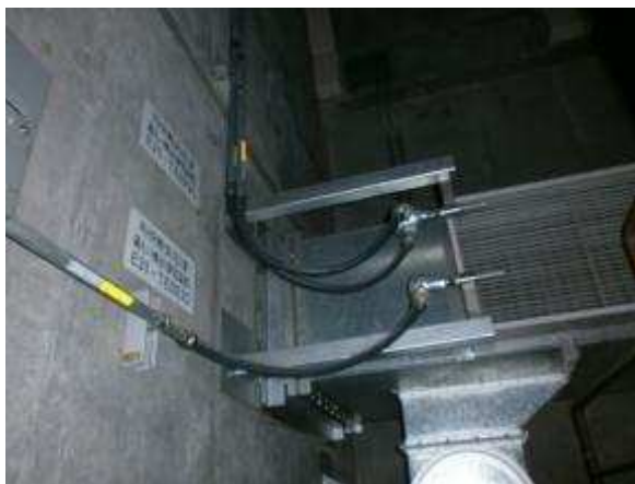
電線管および可とう電線管
