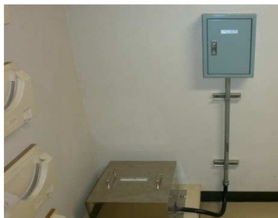
電線管および可とう電線管
