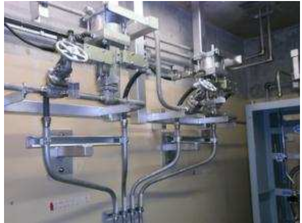
電線管および可とう電線管
