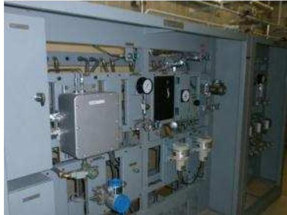
CAMS ラックおよび可とう電線管
