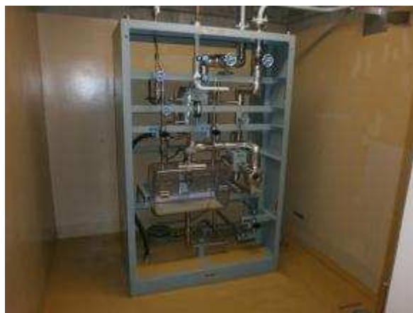
サンプルングラックおよび可とう電線管
