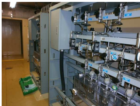
導電率計ラックおよび可とう電線管
