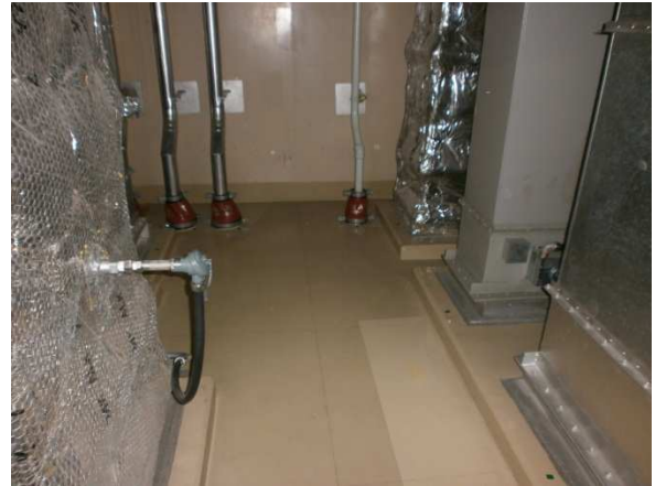
電線管および可とう電線管
