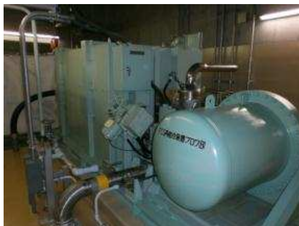
再結合装置および可とう電線管
