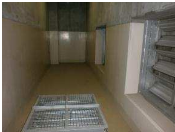
原子炉補機(HPCS)室排気チャンバ室
