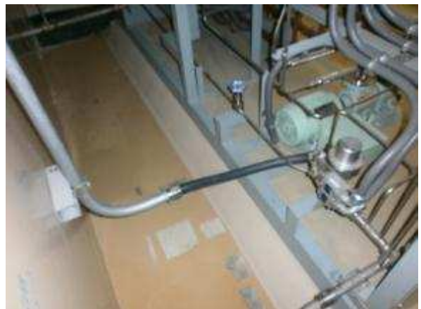
電線管および可とう電線管
