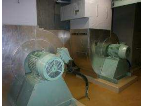
送風機および可とう電線管
