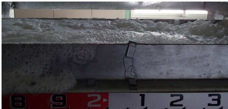
図 6 消火後の泡消火剤付着状況
