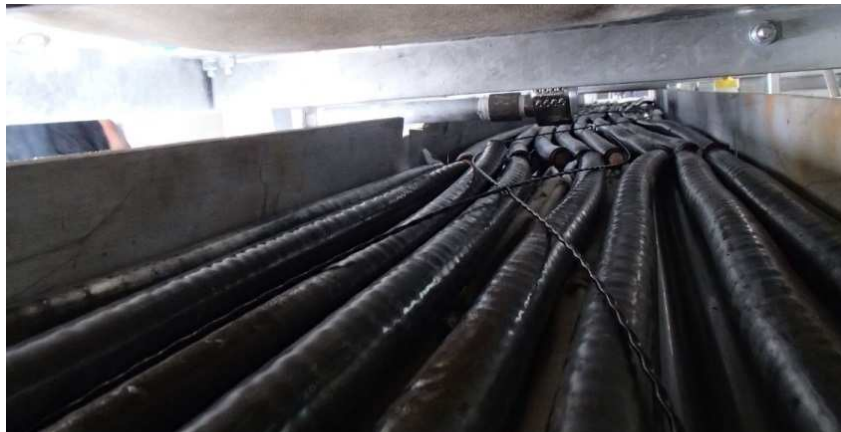
図 2 火災前のケーブルトレイ
