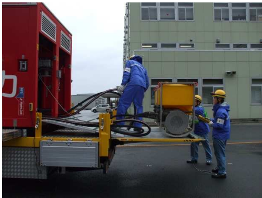
水中ポンプの取り出し
