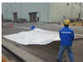
⑤ケーブル保護シート布設
