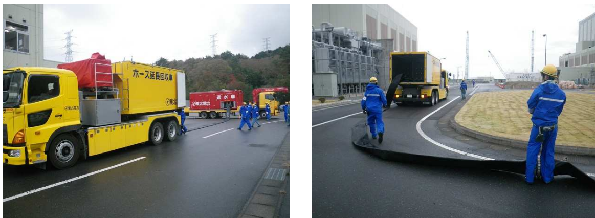
車両による海水送水ホースの設置
