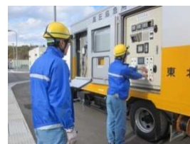
⑧電源車起動
