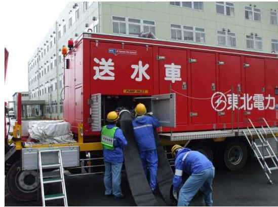
取水用ホースの接続
