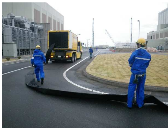
車両による送水用ホースの設置
