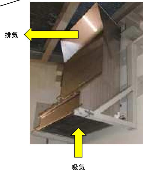
静的触媒式水素再結合装置
