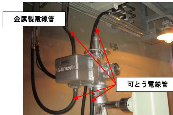
金属製電線管の使用
