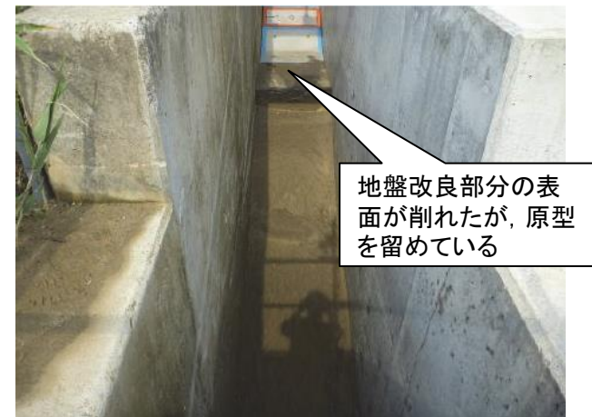
◆ ケース5-2-2m(地盤改良あり)の試験終了後状況
