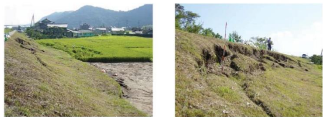
写真-5 法尻付近まで達するすべりの事例
