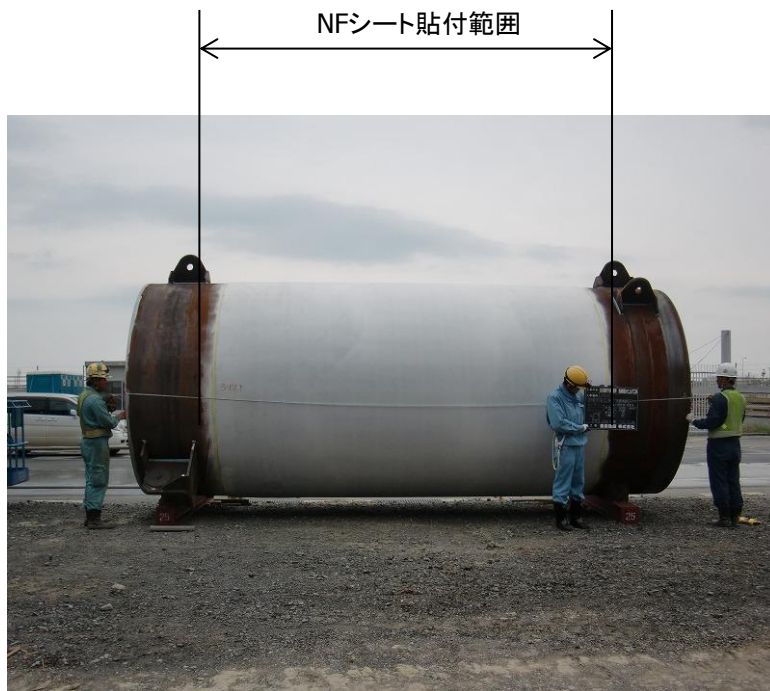
NFシート貼付状況
