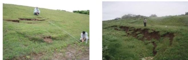
写真-6 すべりによって発生した亀裂の事例
