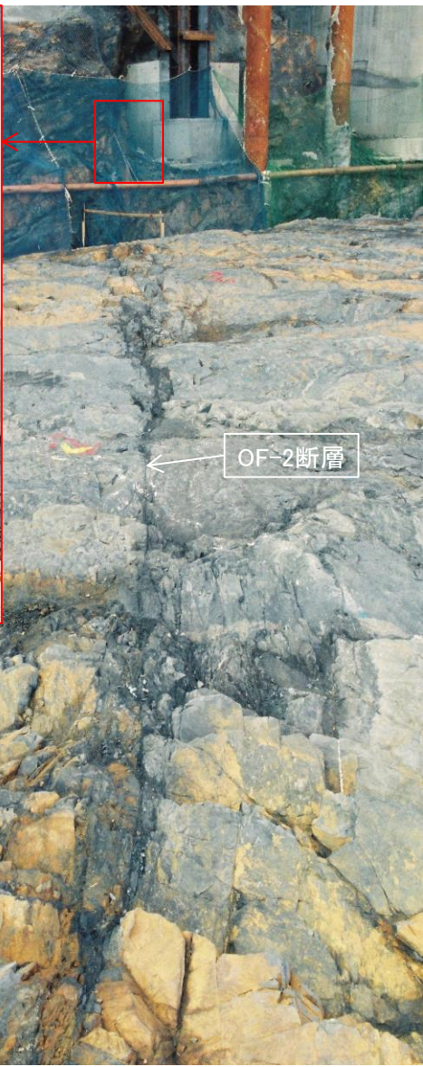
2号原子炉建屋底盤写真 (OF-2断層:東から西を望む)
