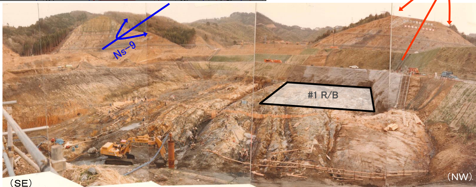
敷地内の褶曲構造(1号炉掘削時の基盤岩)(1980年(昭和55年)撮影)
