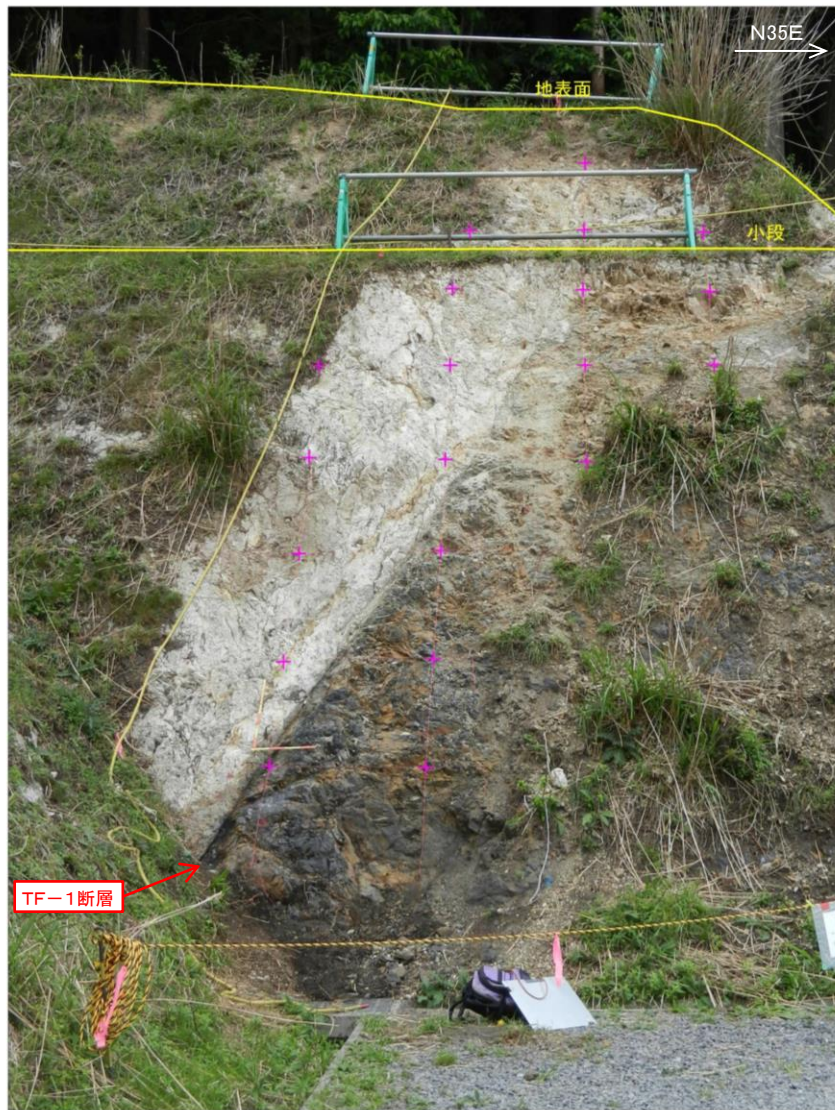
TF-1断層露頭写真
