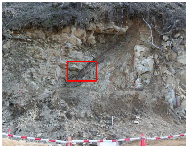
SF-2②断層露頭写真
