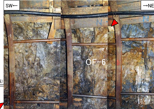
3号炉試掘坑2坑北西壁で確認したOF-6断層(右:写真, 左上:スケッチ)
