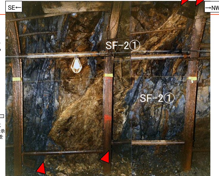
2号炉試掘坑A坑南西壁で確認したSF-2①断層(左:スケッチ, 右:写真)
