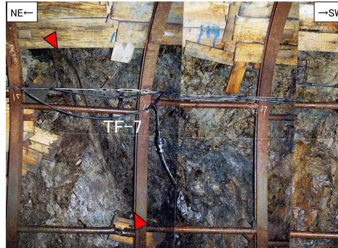
3号炉試掘坑2坑南東壁で確認したTF-7断層(左:写真, 右:スケッチ)
