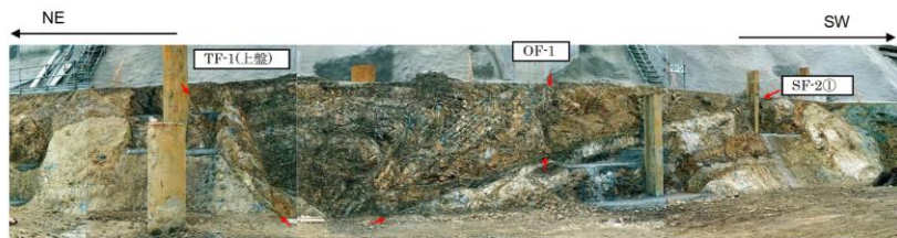
<観察法面の遠景>
