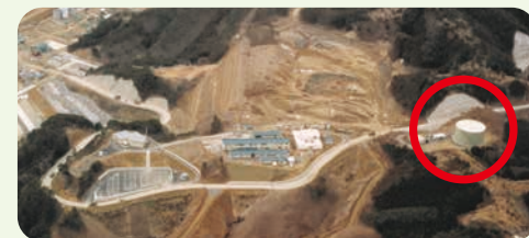
1号機建設時は1基(1979年撮影)
