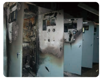
高圧電源盤の主要負荷
