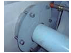
貫通部水密化施工例
