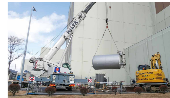
窒素ガス供給装置のタンクを撤去
