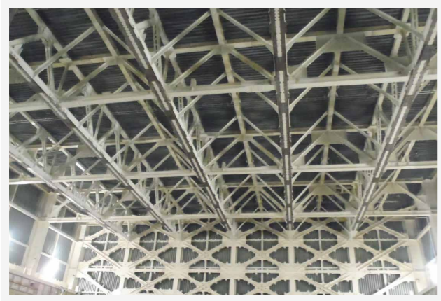
原子炉建屋の耐震工事
