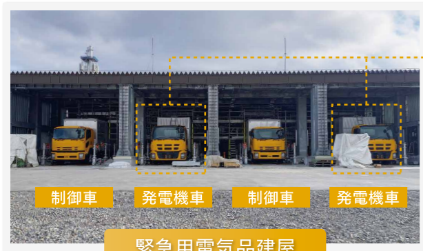
緊急用電気品建屋
