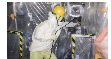
除去作業の様子
