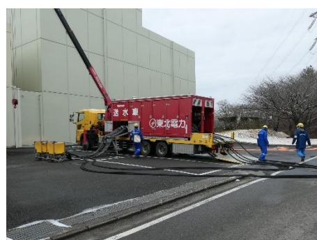
大容量送水ポンプ車 のホース敷設
