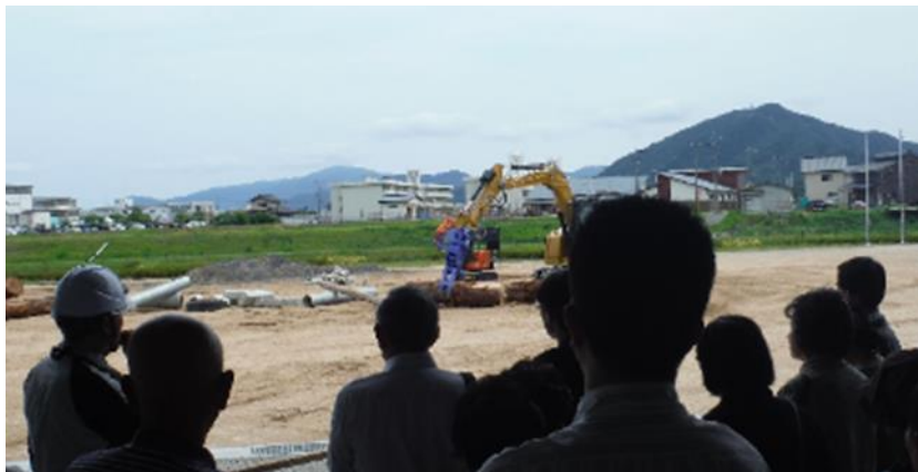
無線重機視察
