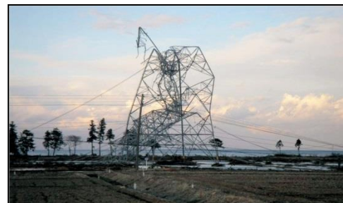
折損した送電鉄塔(福島県)
