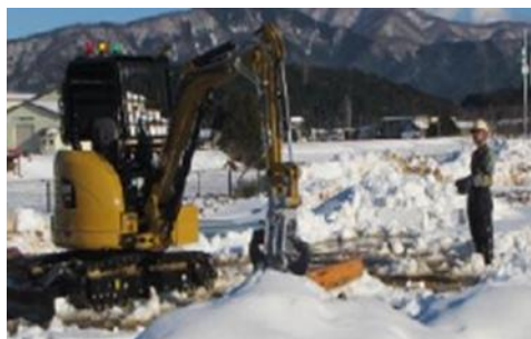
無線重機訓練
