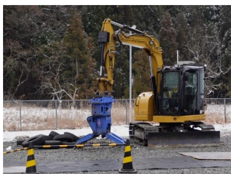
無線重機・ロボットの 操作
