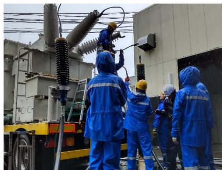
移動用変電設備車への 66kVケーブルの接続
