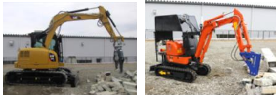
小型・大型無線重機 (屋外のがれきなどの除去)
