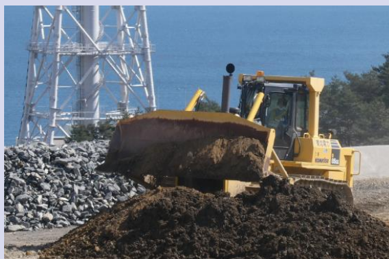
がれき撤去訓練
