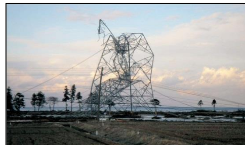
折損した送電鉄塔(福島県)
