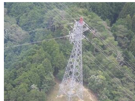
上空からの外部電源の状況 (送電線復旧作業箇所)
