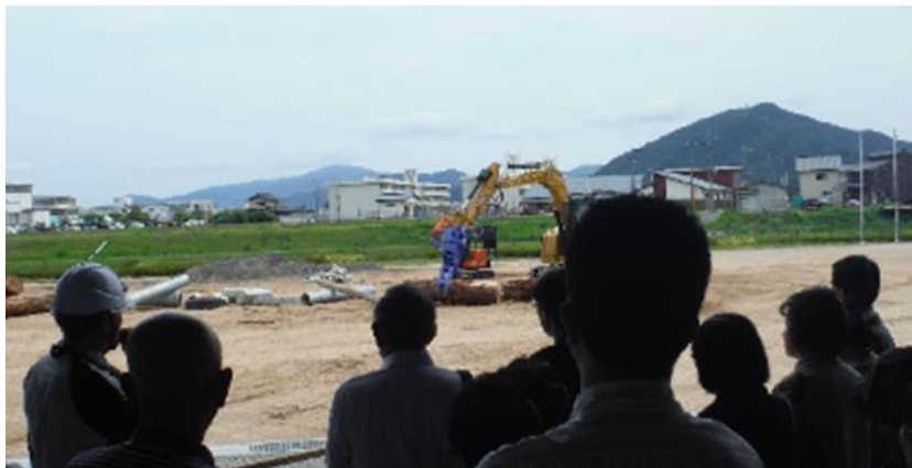
無線重機視察
