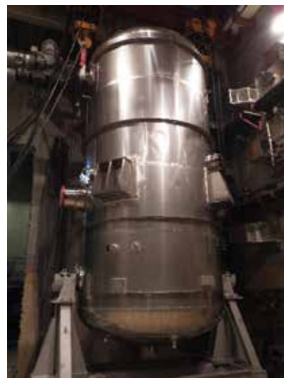
フィルター付格納容器ベント設備※の設置工事 (女川原子力発電所)
