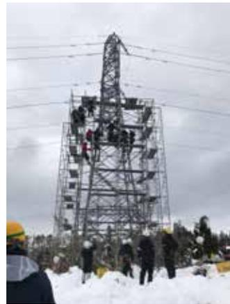
着雪により変形した鉄塔の復旧作業ならびに高圧応急電源車による供給力確保
