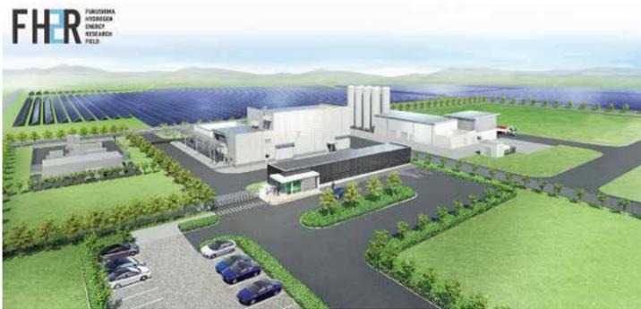
福島水素エネルギー研究フィールドでは隣接する太陽光発電と電力系統からの電力を用いて、年間最大900t規模の水素を製造し、貯蔵・供給します。水素の製造・貯蔵は、水素需要予測システムからの市場における水素需要予測に基づいて行います。また、水素製造装置の水素製造量を調節することにより、電力系統の需給バランス調整を行います。2019年10月までに本システムの建設を完了させ、試運転を開始、2020年7月までに実証運用と水素の輸送を開始する予定です。
