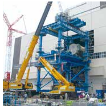
能代火力発電所3号機 発電機搬入の様子（2018年7月）
