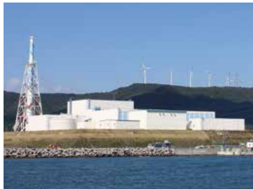
東通原子力発電所（青森県東通村）
