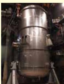
女川原子力発電所に設置されたフィルター付格納容器ベント設備
