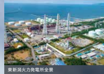
東新潟火力発電所全景
