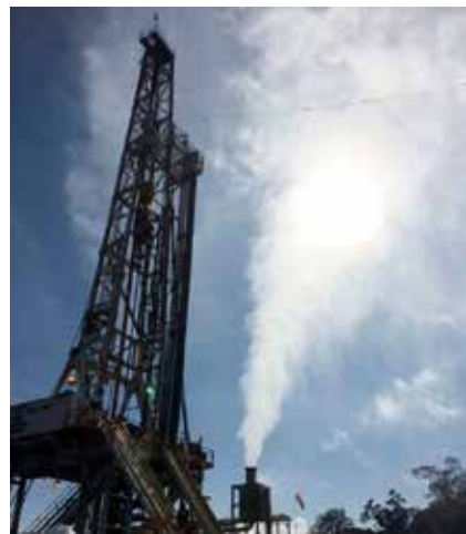
建設工事が進むランタウ・デダップ地熱発電所 (インドネシア共和国)
