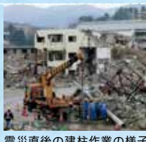
震災直後の建柱作業の様子
