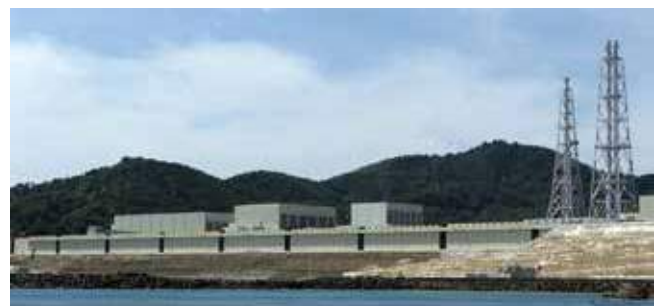
海抜約29m、全長約800mにもおよぶ防波堤の設置工事を実施している女川原子力発電所（2017年6月撮影）
