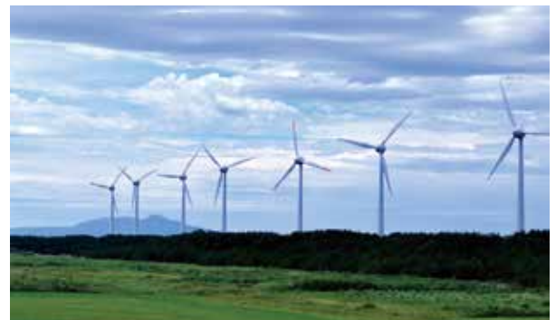
能代風力発電所
