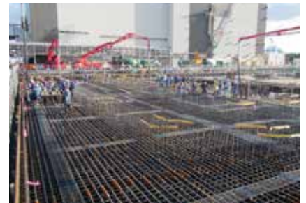
能代火力発電所3号機基礎工事でのコンクリート大量打設の状況
