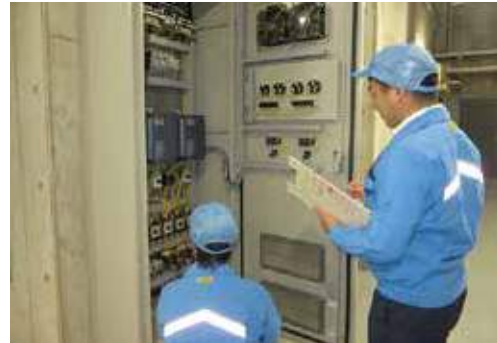
お客さま設備調査の様子
