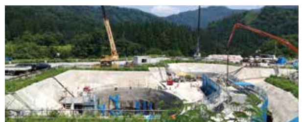
玉川第二発電所建設の様子
