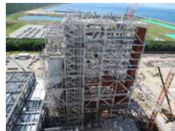
能代火力発電所3号機建設工事状況 (ボイラー設置工事)
