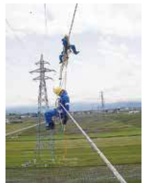
送電線点検作業
