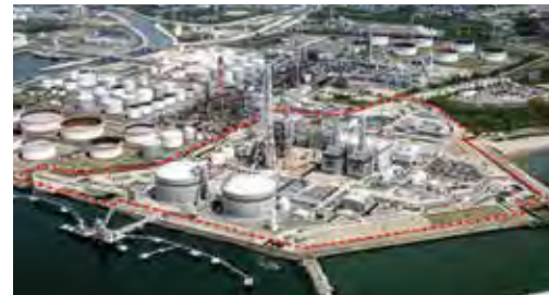
新仙台火力発電所3号系列
