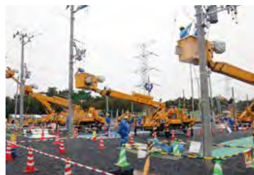
低圧線の断線修理の訓練をする様子（配電部門）
