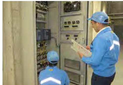
お客さま設備調査の様子
