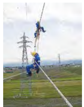
送電線点検作業
