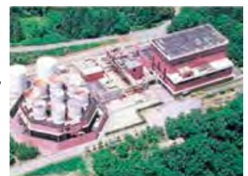
柳津西山地熱発電所 (福島県柳津町)
