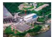
リニューアル工事が進む 鹿瀬発電所(新潟県阿賀町)
