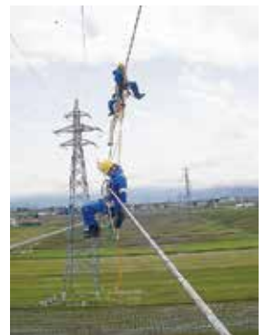
電線点検作業
