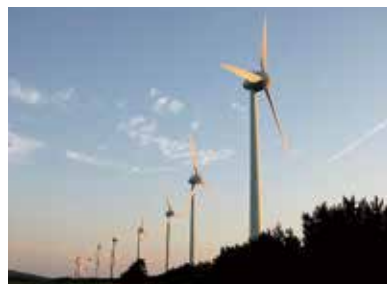
能代風力発電所（1万4,400kW）（秋田県能代市） （東北自然エネルギー（株））
