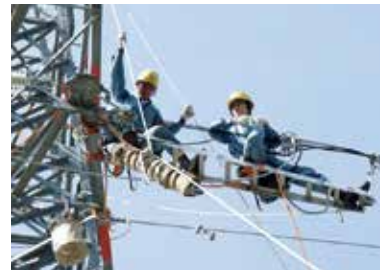
総合技能大会 送電部門 (66kVがいし取替)
