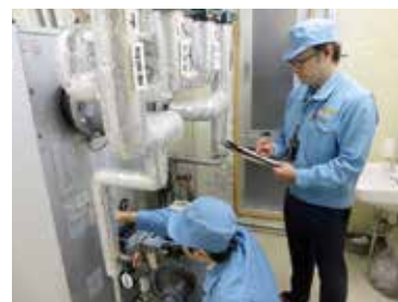
現地調査の様子
