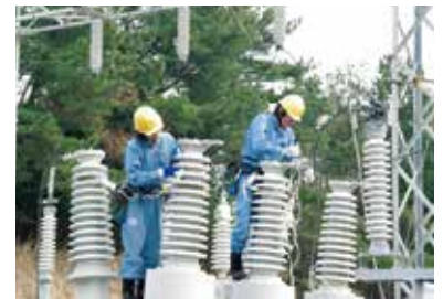
総合技能大会 変電部門 (66kV真空遮断器 臨時点検)
