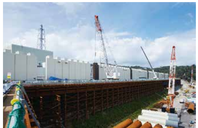
女川原子力発電所防潮堤かさ上げ工事の様子／現在の防潮堤を海拔約29mにかさ上げし、津波（想定津波高23.1m）から発電所を守る工事を進めている。
