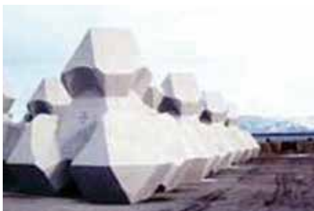
フライアッシュ混合コンクリートで製造された消波ブロック
