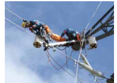
技能大会 送電部門 (66kVがいし取替)
