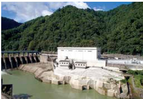
豊実発電所（新潟県阿賀町）
