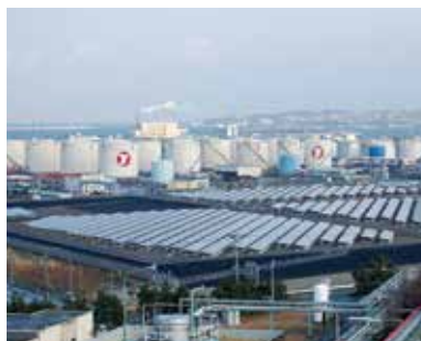
八戸太陽光発電所
