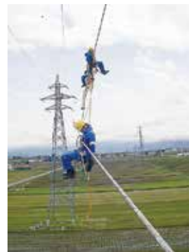
電線点検作業
