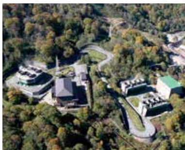
葛根田地熱発電所
