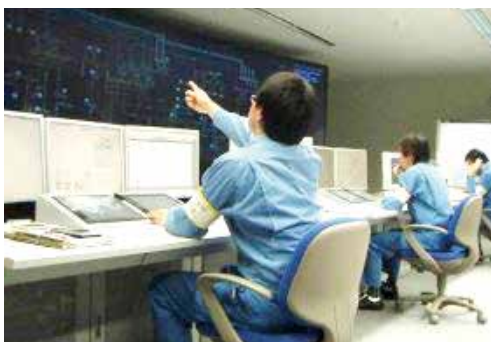
技能大会 給電部門 (系統事故復旧操作)
