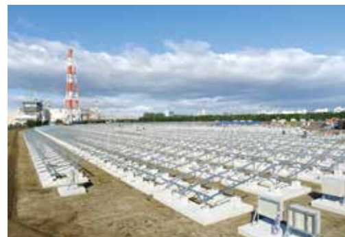
環境に配慮した資材の導入例 (アレイ架台に少ないめっき量で耐久性のあるプレめっき鋼板を採用)
