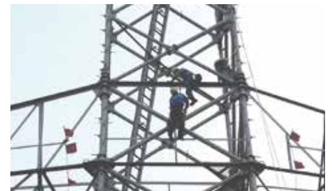
技能大会 送電部門 (鉄塔の部材取替)
