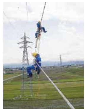
電線点検作業
