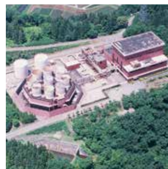
単機として国内最大の出力を誇る柳津西山地熱発電所（65,000kW）（福島県柳津町）
