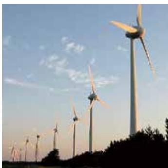
能代風力発電所 (14,400kW) (秋田県能代市) (東北自然エネルギー開発(株))
