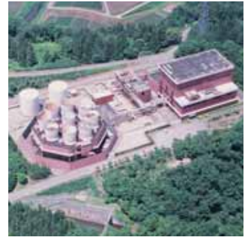
単機として国内最大の出力を誇る柳津西山地熱発電所 (65,000kW) (福島県柳津町)
