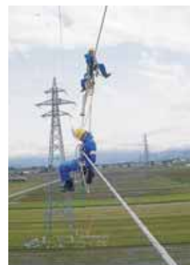
電線点検作業
