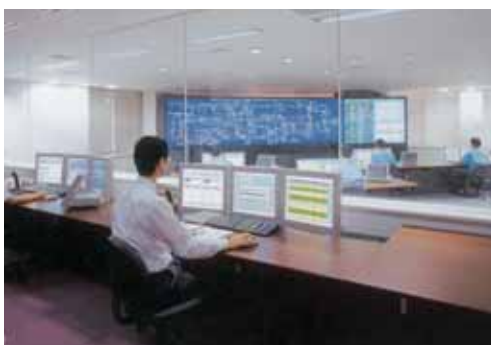
事故復旧訓練
