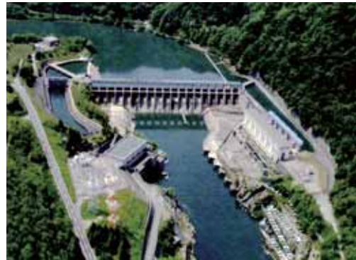
リニューアル工事を行っている豊実（とよみ）発電所（新潟県東蒲原郡）
