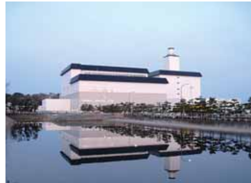
白壁と瓦葺屋根の蔵をイメージとした外観で、日本三景の一つである松島の景観にも配慮した仙台火力発電所4号機(宮城県七ヶ浜町)
