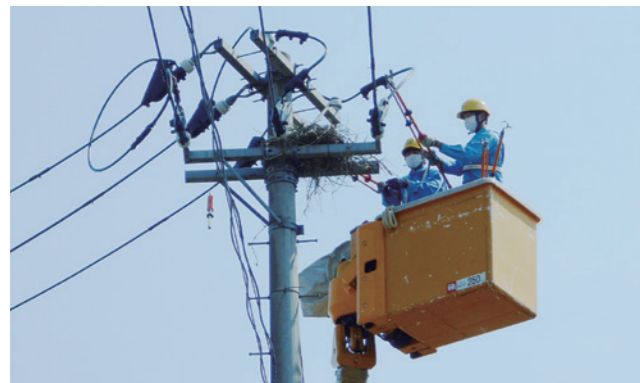
停電の未然防止に向けたカラスの巣の撤去作業
