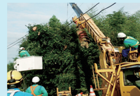
倒木を除去しながらの作業(台風15号)
