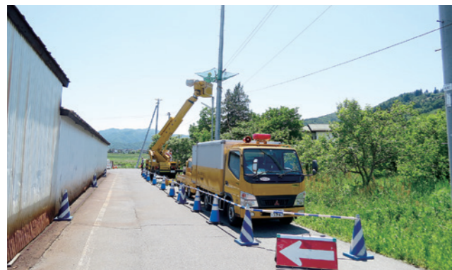
工事範囲のバリケード設置
