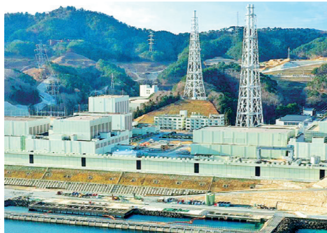
安全対策工事が進む 女川原子力発電所
