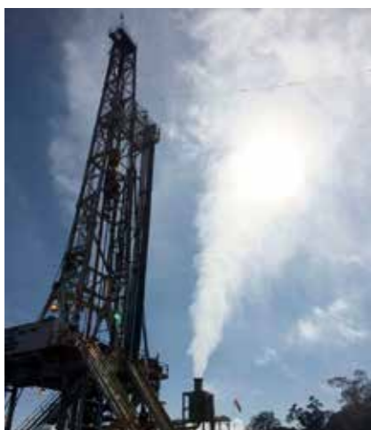
建設工事が進むランタウ・デダツプ地熱発電所 (インドネシア共和国)
