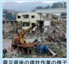
震災直後の建柱作業の様子
