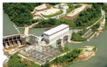
大規模改修工事を終えた鹿瀬発電所
