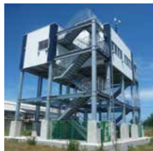
酒田共同火力発電所 「石炭埠頭津波避難塔」
