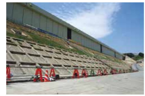
防潮堤のかさ上げ工事（女川原子力発電所）
