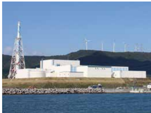
東通原子力発電所(青森県東通村)
