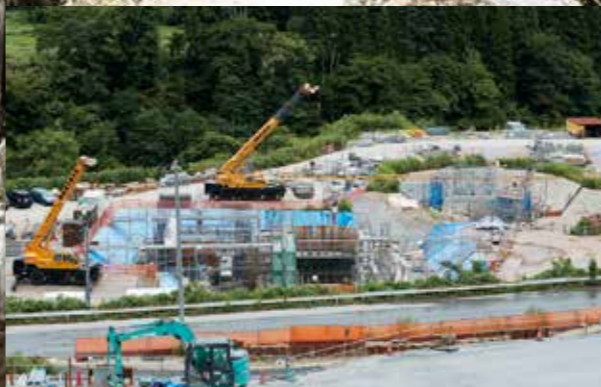
玉川第二発電所は、有効落差66.8mを利用して水力発電を行う水路式発電所。導水路などの土木工事が進められるとともに、本館新築工事も2018年6月に着工しました。
