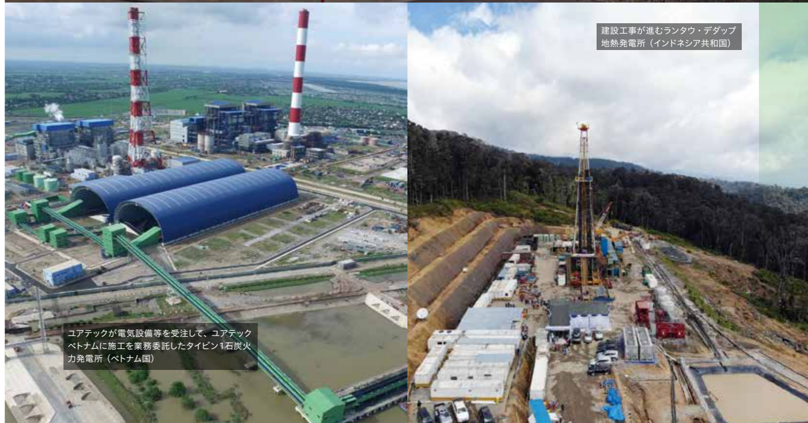
岩手中部(金ヶ崎)工業団地に増設したLNG共同サテライト設備
