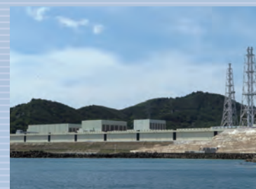
女川原子力発電所 (宮城県女川町・石巻市)
