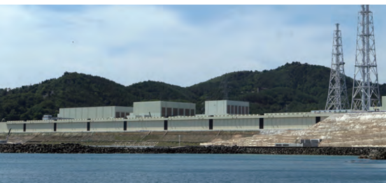
海抜約29m、全長約800mにもおよぶ防波堤の設置工事を実施している女川原子力発電所(2017年6月撮影)
