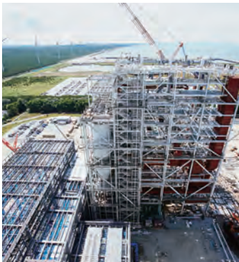
建設工事が進む能代火力発電所3号機
