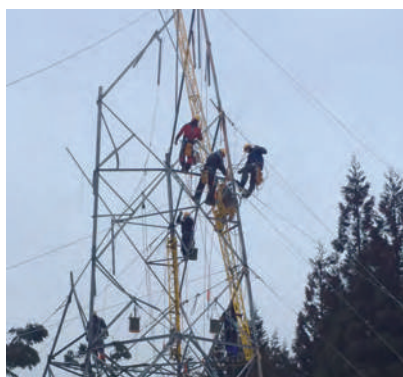
降雪と寒風の中での鉄塔建替作業
