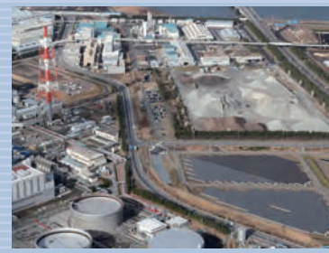
八戸太陽光発電所 (青森県八戸市)
