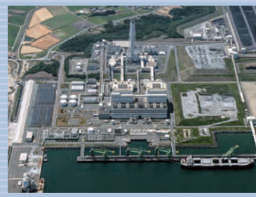
原町火力発電所 (福島県南相馬市)
