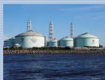
日本海エル・エヌ・ジー 新潟基地 (新潟県聖籠町)
