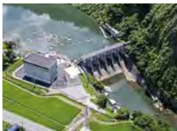
第二荻神発電所(新潟県魚沼市)
