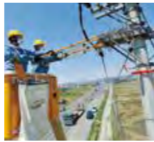
カラスの巣の除去作業
