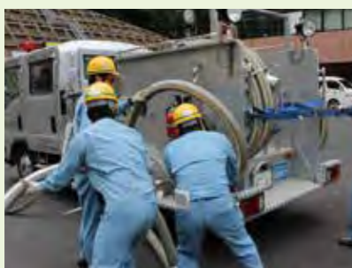
●代替注水車のホース接続訓練
