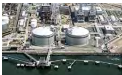
新仙台火力発電所(宮城県仙台市)
