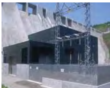
津軽発電所(青森県西目屋村)
