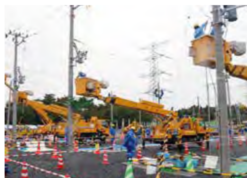
災害時の対応能力向上を目指して低圧線の断線修理の訓練を実施（配電部門）
