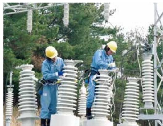
総合技能大会 変電部門 (66kV真空遮断器 臨時点検)
