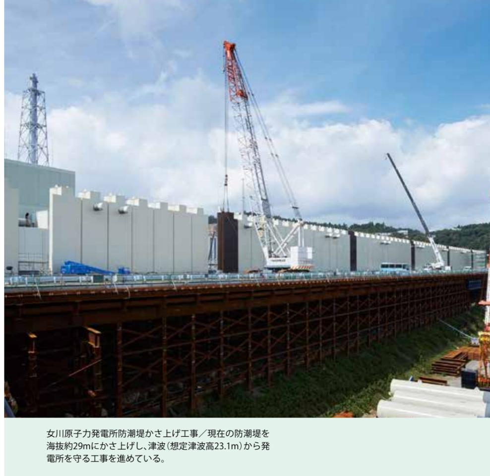
女川原子力発電所防潮堤かさ上げ工事／現在の防潮堤を海拔約29mにかさ上げし、津波(想定津波高23.1m)から発電所を守る工事を進めている。
