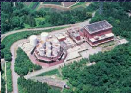
柳津西山地熱発電所 (福島県柳津町)
