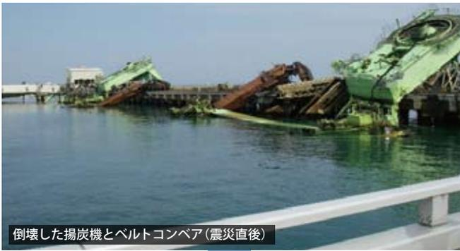
倒壊した揚炭機とベルトコンベア（震災直後）
