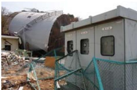
津波により倒壊した1号機重油貯蔵タンク
