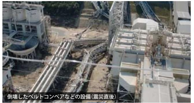
倒壊したベルトコンベアなどの設備（震災直後）
