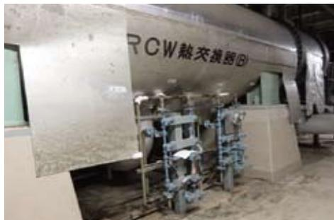
浸水被害のあった2号機補機冷却水系熱交換器室
