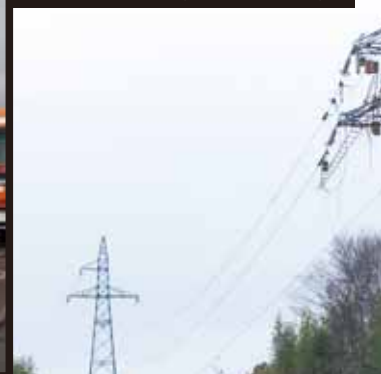
仮鉄柱での送電(宮城県気仙沼市)
