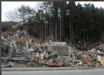
津波の直撃を受けた志津川変電所
