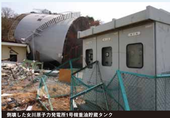
倒壊した女川原子力発電所1号機重油貯蔵タンク
