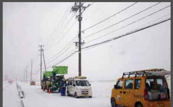
雪の中での改修工事(宮城県石巻市)
