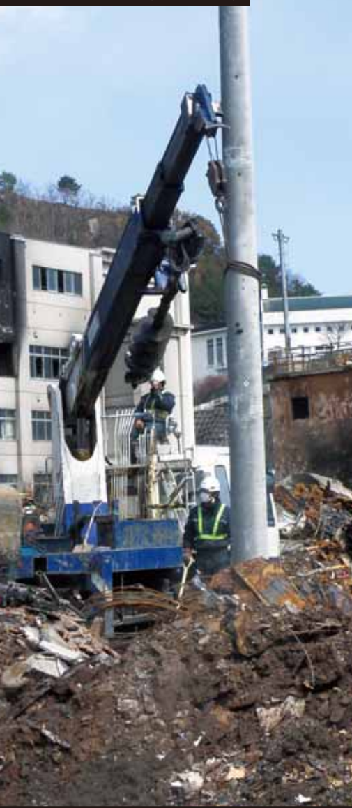
被災地での建柱作業(岩手県大槌町)
