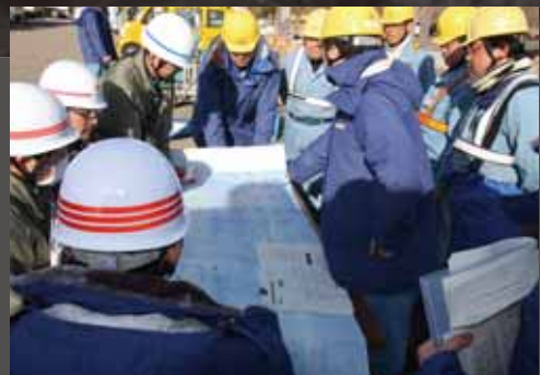
復旧作業班による入念な打ち合わせ
