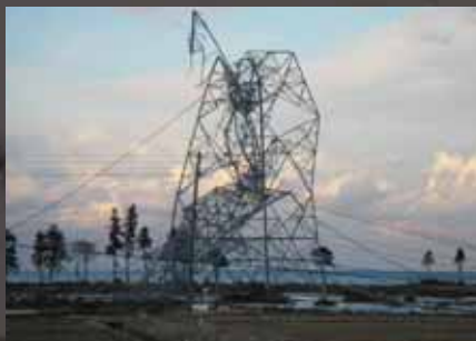
折損した27万ボルト送電鉄塔(福島県南相馬市)
