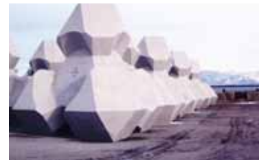
フライアッシュ混合コンクリートで製造された消波ブロック
