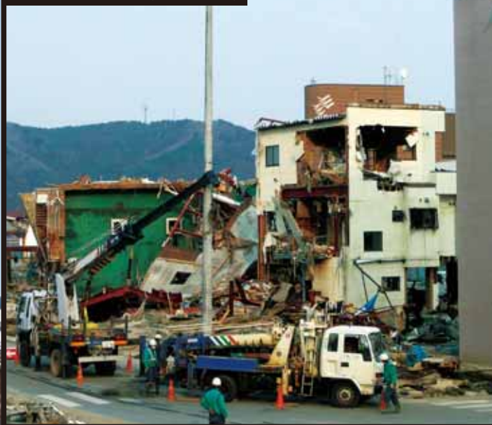
被災地での建柱作業(宮城県女川町)
