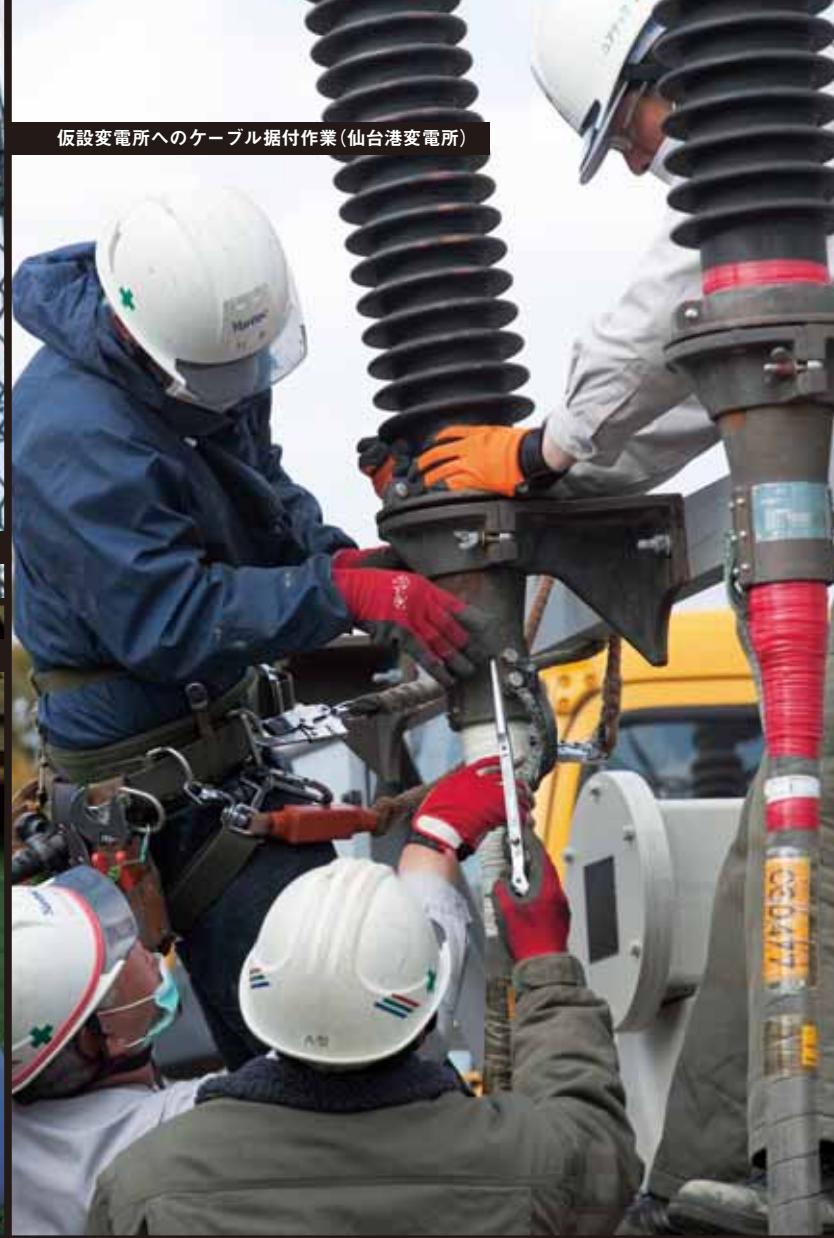
仮設変電所での電線接続作業(仙台港変電所)
