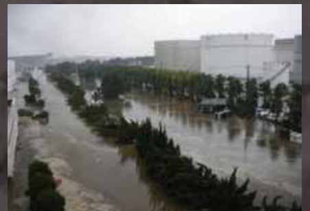
津波直後の新仙台火力発電所
