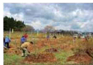
伐採木から作ったチップの敷詰作業(花北営業所)
