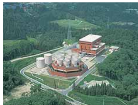
国内最大の出力を誇る 柳津西山地熱発電所 (65,000kW)
