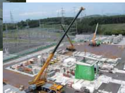
岩手変電所 50万V機器据付作業状況
