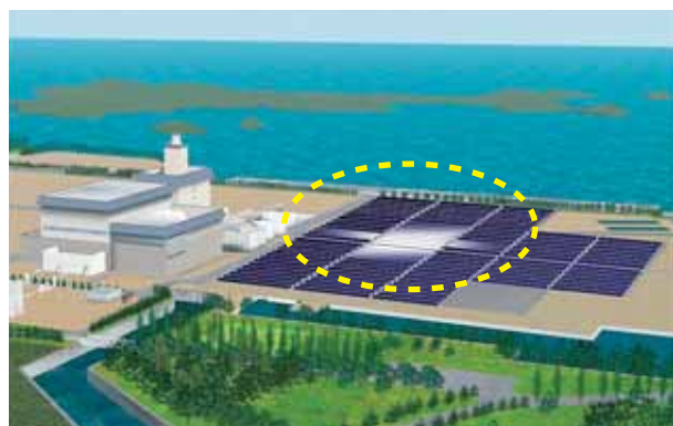
仙台太陽光発電所地点（イメージ）
