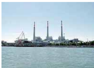
《Before: リブレース前》
