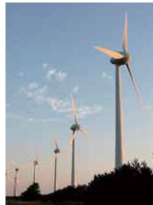
能代風力発電所 (14,400kW) (東北自然エネルギー開発(株))
