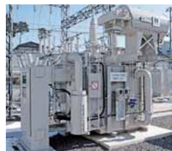
ナタネ油を使用する環境調和型変圧器
