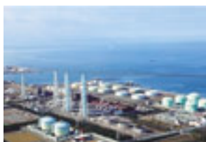
日本で最初に大型コンバインドサイクル発電を導入した東新潟火力発電所
