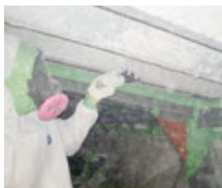
石綿吹付箇所の除去作業
