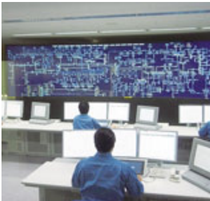
給電シミュレータ
