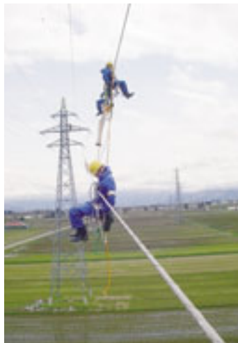
電線点検作業の様子
