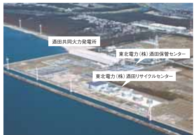
建設が進む酒田リサイクルセンター
