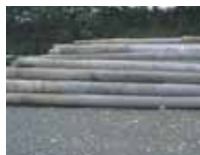
古コンクリート柱
