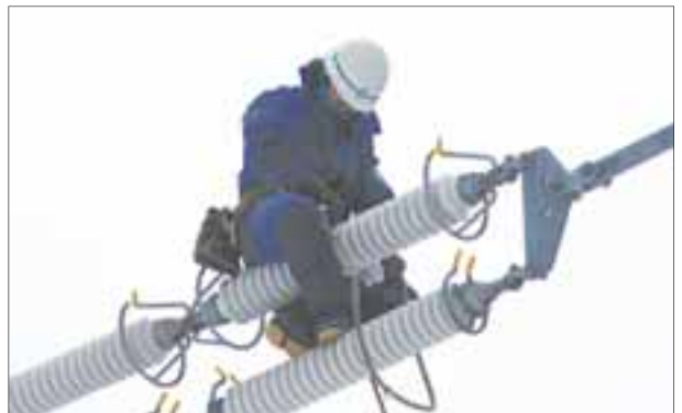
がいしの清掃作業は困難を極めた
