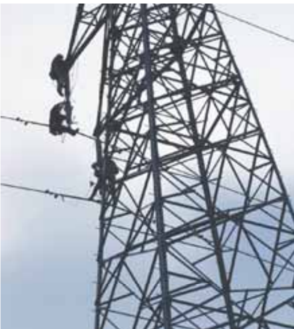
悪天候の中、復旧作業が続けられた
